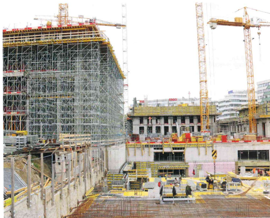
Stand der Hochbauarbeiten im November.
